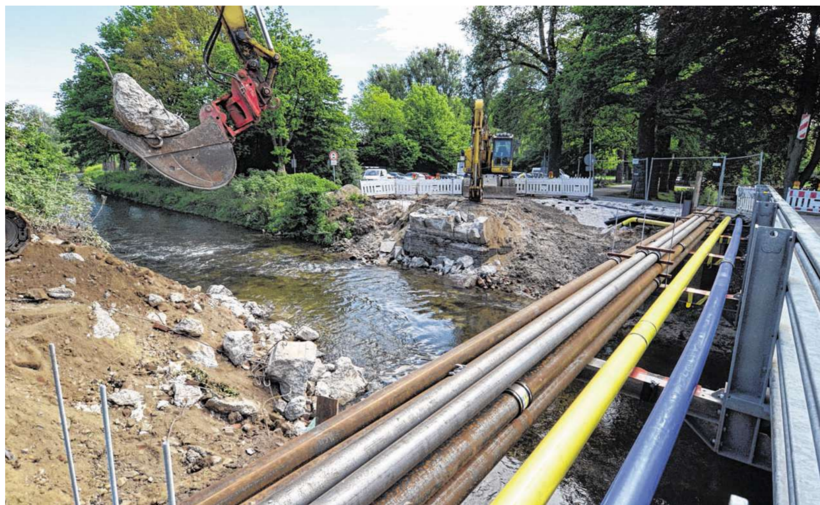
Knirsch, knack, und schon ist die Brücke weg. Dank einer Behelfsbrücke kommt man dennoch trockenen Fußes rüber zur Burg. Foto: Dettmar Fischer
