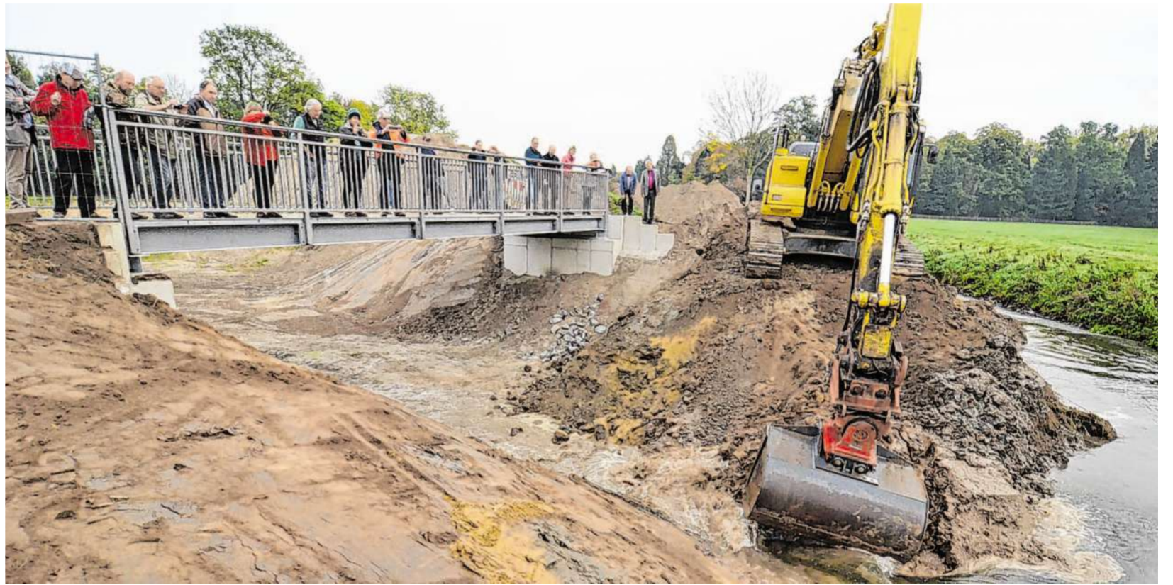
Langsam wälzte der Bagger die Erdmassen beiseite...
