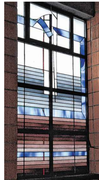
Neben dem Hauptfenster am Eingangsportal sind weitere Schaffrath-Fenster zu finden.
