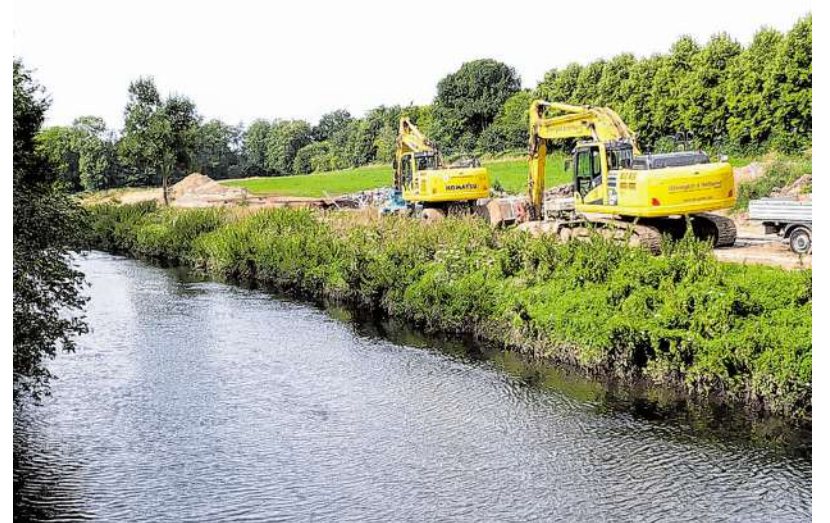
Neben dem derzeitigen Wurmverlauf arbeiten die Bagger an dem neuen Flussbett. Fotos: Udo Stüßler
