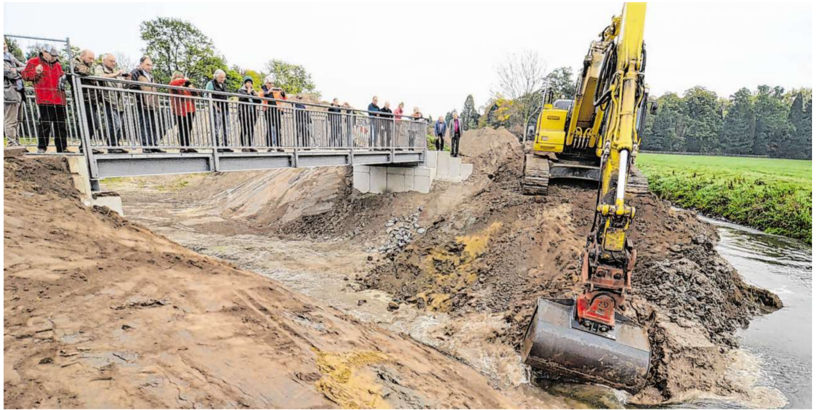
Langsam wälzte der Bagger die Erdmassen beiseite...
