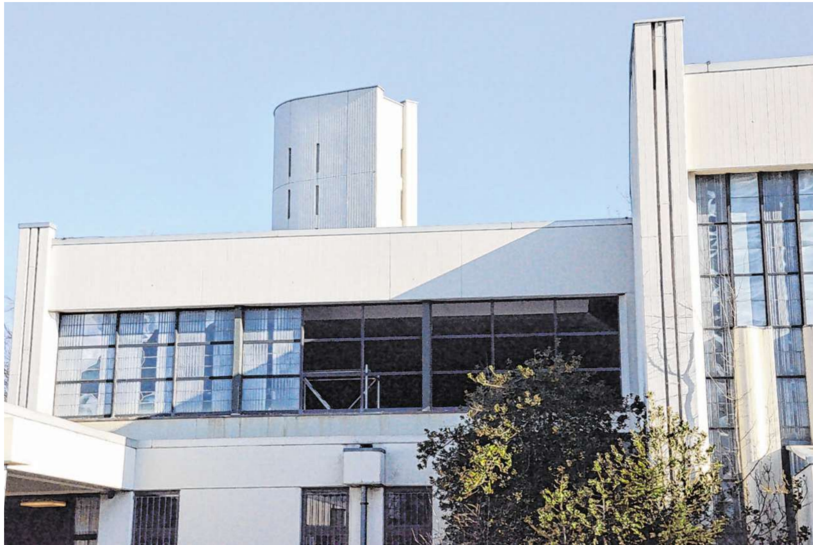
Mit dem Ausbau der Fenster wurde schon begonnen.
