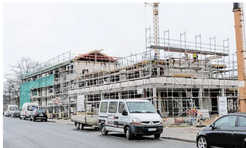
Während die Kirche abgerissen wird, wird in unmittelbarer Nachbarschaft auf Hochtoren gebaut.
