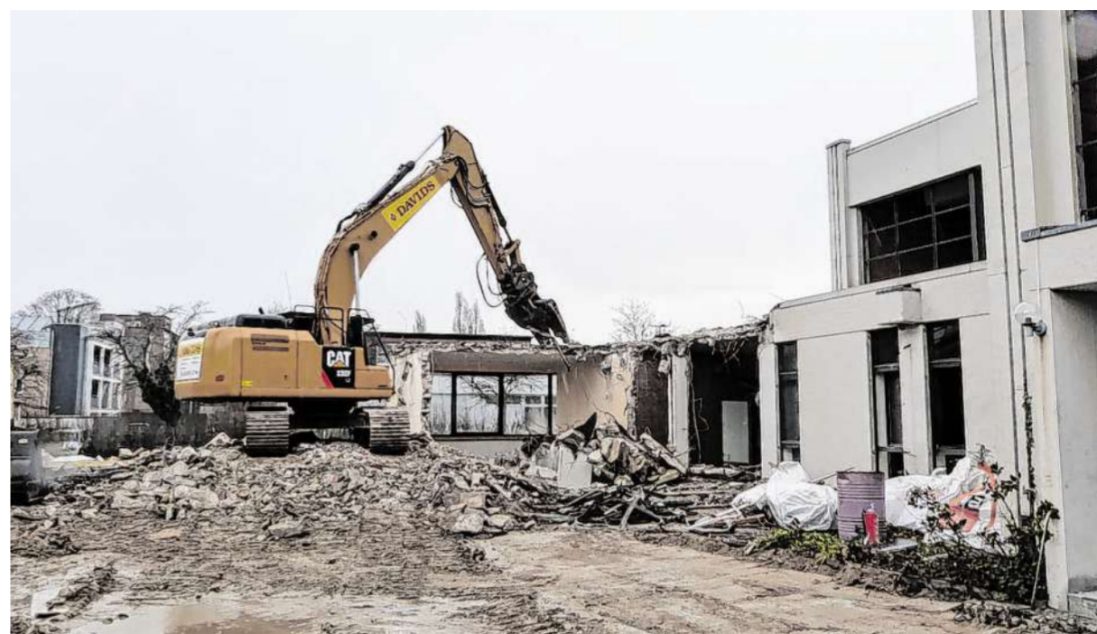
Mit der Betonschere zerlegt der Bagger derzeit noch die Nebengebäude der Bauchemer Pfarrkirche. Der Abriss der Kirche beginnt in der kommenden Woche. Fotos: Udo Stüßer
