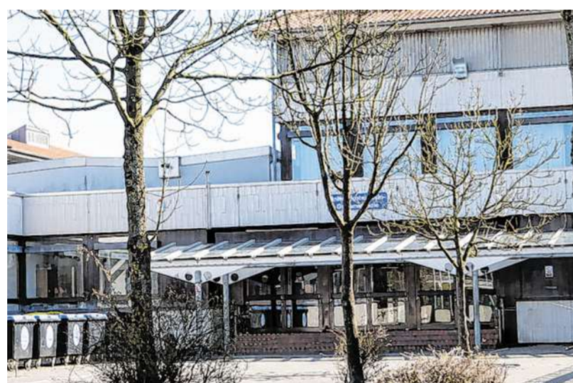
Seit 2010 ist das Eichendorff-Kolleg als Abteilung IV in die Gesamtschule integriert. Im Sommer 2019 wird sie geschlossen.
