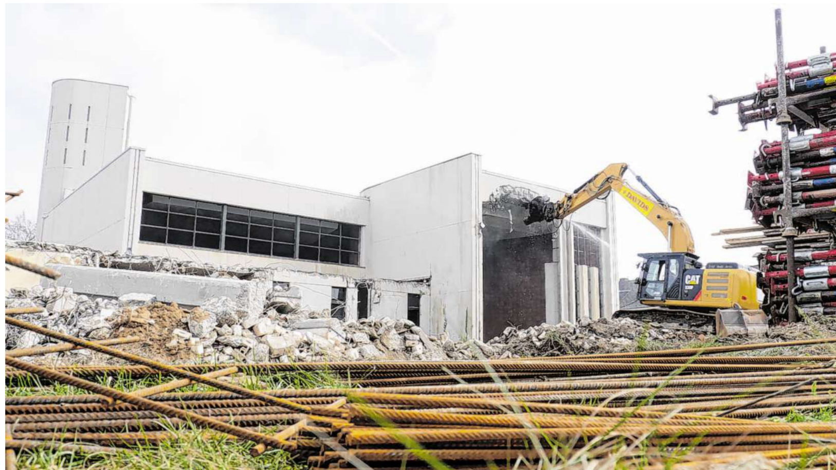
Ein Stück Ortsgeschichte verschwindet aus Bauchem. Langsam, aber unaufhaltsam verrichtet der Abrissbagger sein Werk.
