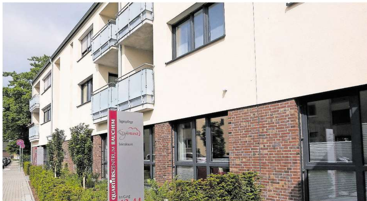
Im ersten Bauabschnitt des Sozialzentrums herrscht reges Leben: Die Quartiersstube und das Café Franz werden von Vereinen und Bürgern gut angenommen.
